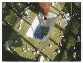
Die Terrassenkonstruktion wurde bis auf die Rohdecke geöffnet. Die gesamte Konstruktion ist hier trocken. Auch in den darunterliegenden Räumen wurden keinerlei Schäden festgestellt.
